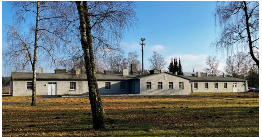
Entlausungsbaracke von Süd-Westen (Foto: LWL-BLB)
